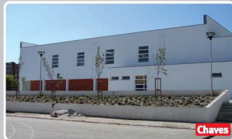
Pavilhão Gimnodesportivo da EB 23 Dr. Francisco Gonçalves Carneiro Rua Contador de Argote. 5400-205 Chaves Tel: (+351) 276 340 360 · Fax: (+351) 276 340 368 info@em23-dr-f-g-carneiro.rcts.pt
